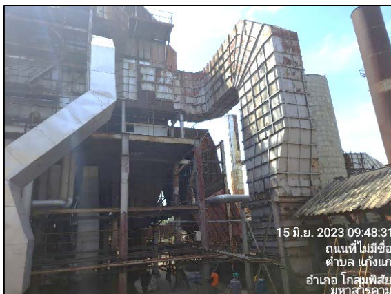
ภาพที่ 2.2-1 ระบบดักฝุ่นแบบมัลติไซโคลอน
