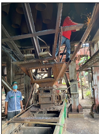
ภาพที่ 2.2-3 การซ่อมบำรุงระบบบำบัดมลพิษทางอากาศ
