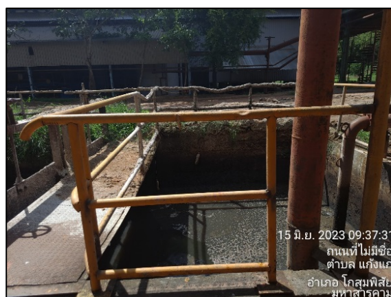
ภาพที่ 2.2-19 รางและบ่อรวบรวมน้ำทิ้งจากกระบวนการผลิต
