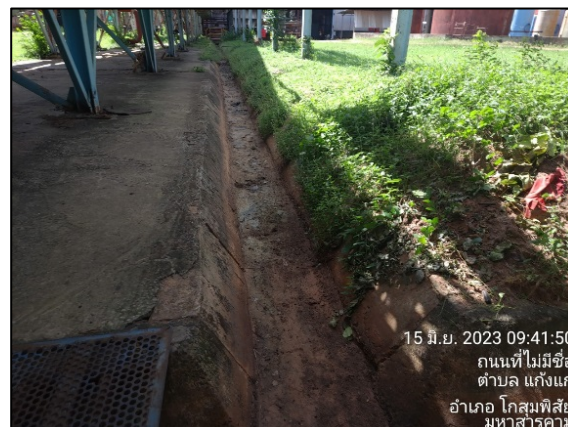
ภาพที่ 2.2-46 รางรวบรวมน้ำฝนรอบพื้นที่โครงการ
