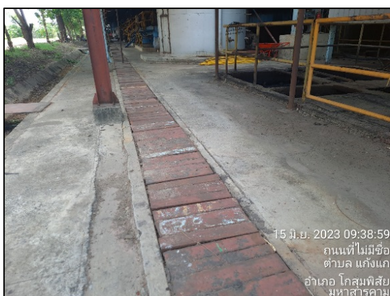
ภาพที่ 2.2-19 รางและบ่อรวบรวมน้ำทิ้งจากกระบวนการผลิต
