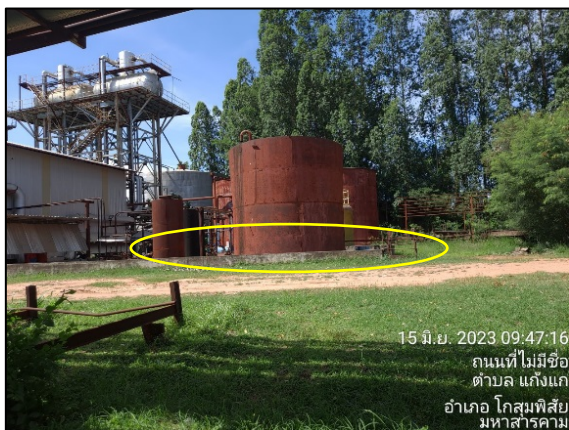
ภาพที่ 2.2-16 คันคอนกรีตล้อมรอบลานถังน้ำมันเตา
